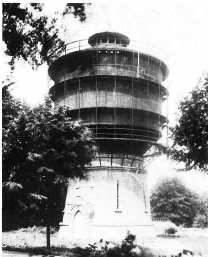
Alter Wasserspeicher auf der Gabjei, der 1884 in Betrieb genommen und 1936 um 12 Meter erhöht wurde. Er diente als Ausgleichbehälter für die Wasserhochdruckzone, bis er 1952 durch den neuen jetzigen Wasserturm ersetzt wurde. Foto: Stadtwerke Brühl
